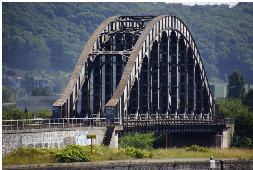
Pont Vierendeel (Photo Nicolas Janberg, @Structurae: 207478)
