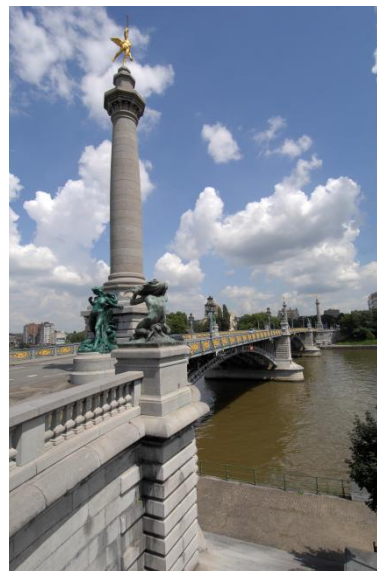
Pont de Fragnée (Photo G. Focant © SPW)
